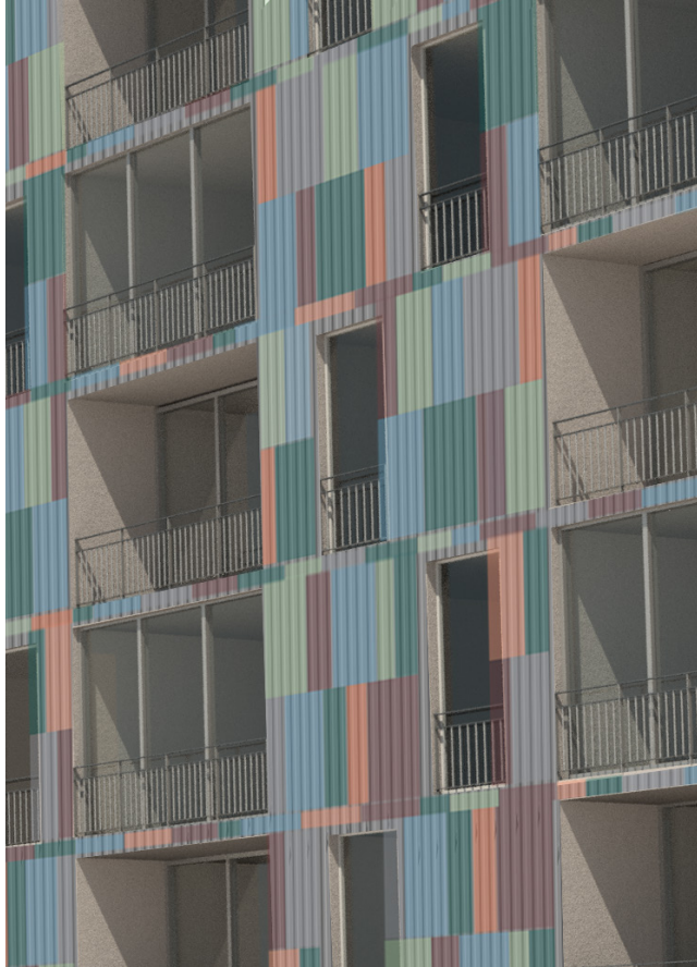
Fassadenbild Ansicht Süd
